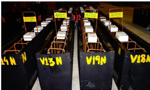
Figura 2 – Detalhe das formas e chaves de cisalhamento
